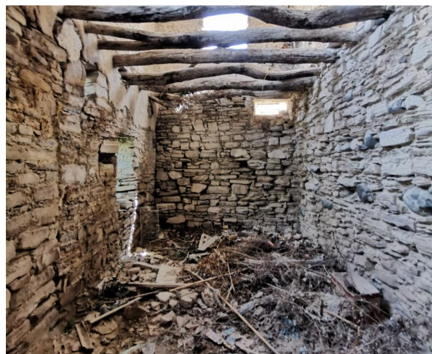
Καλή κατάσταση τοιχοποιίας της οικοδομής
