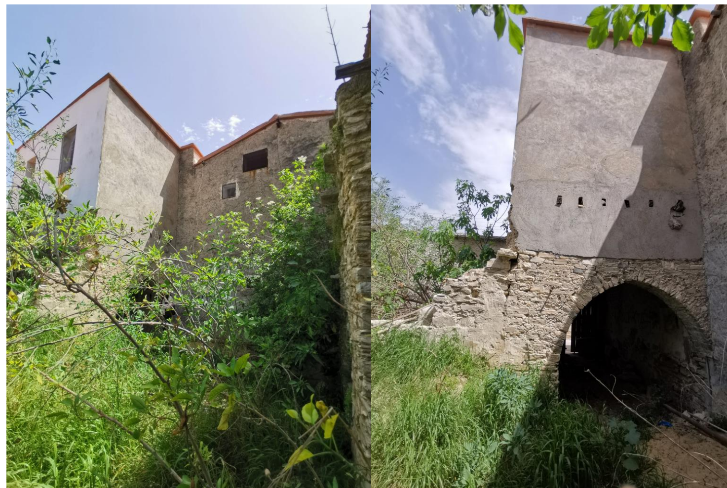
Φωτογραφίες εσωτερικής αυλής
